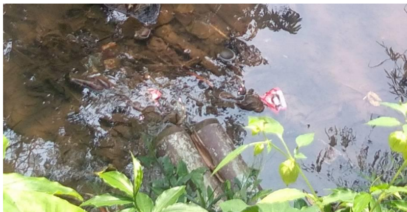
Gambar 11 Intake pada WTP Ciapus
